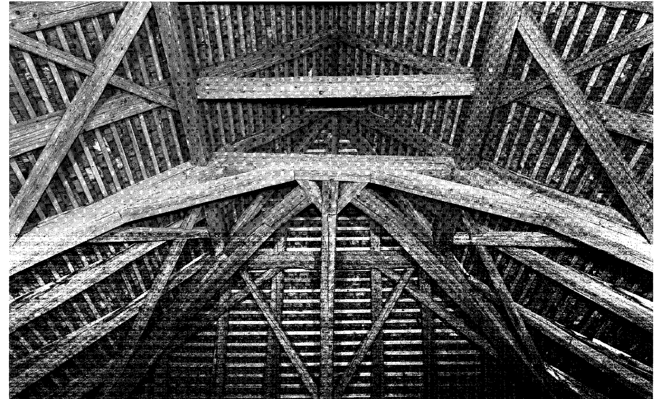
Charpente : vue générale vers l'est
