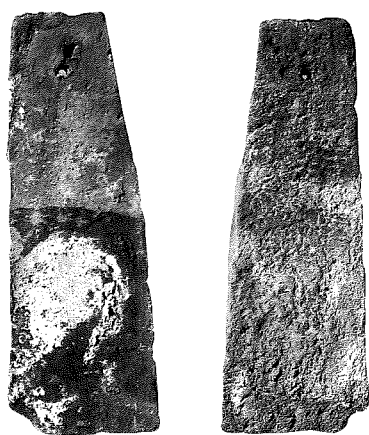
Fig.4 - Demi-tuile percée d'un trou permettant de l'accrocher au lattage par un clou (MHA VD 274/21)
