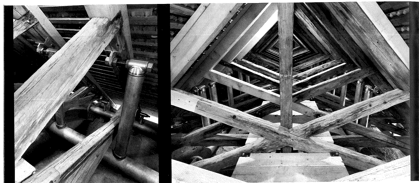
Charpente restaurée de la nef: a) Détail d'une articulation b) Vue d'ensemble
