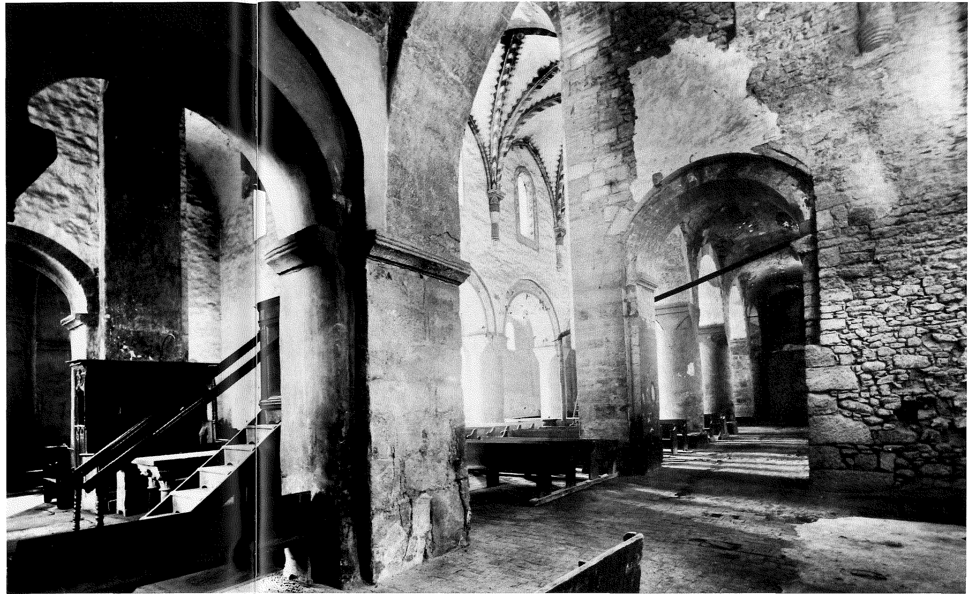
Intérieur en direction de l'Ouest, avant travaux (Musée Elysée)
