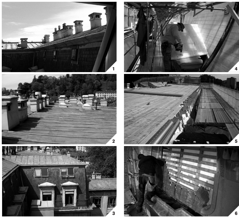
1/ 2/ 3/ avant travaux 4/ 5/ 6/ pendant travaux 7/ 8/ 9/ après travaux
