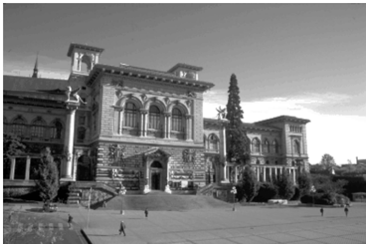
Le Palais de Rumine: il hébergera provisoirement les travaux du Grand Conseil.
