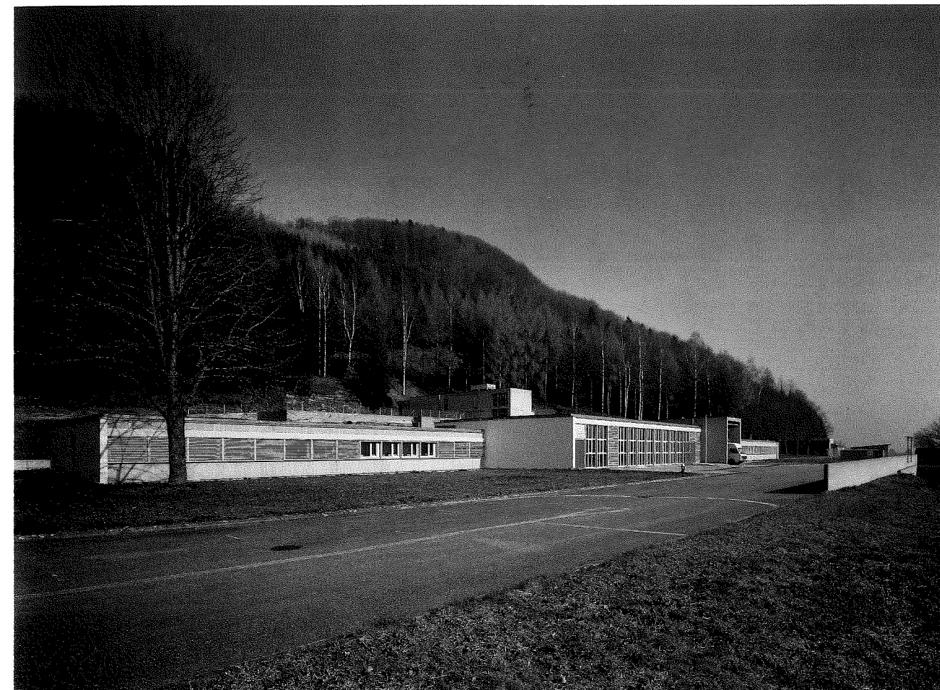
Vue sud-ouest des bâtiments de service
