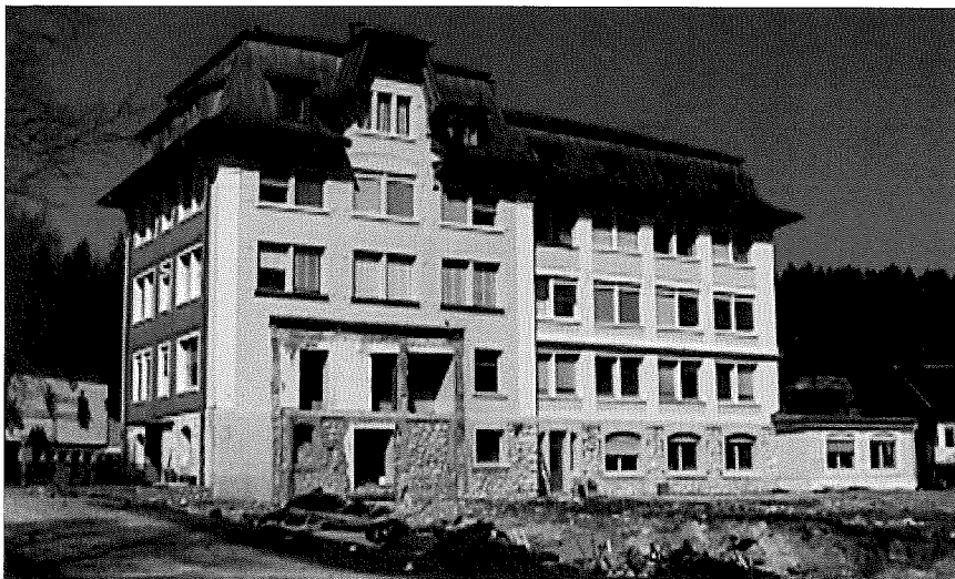
Trace de la liaison révélée par la démolition
