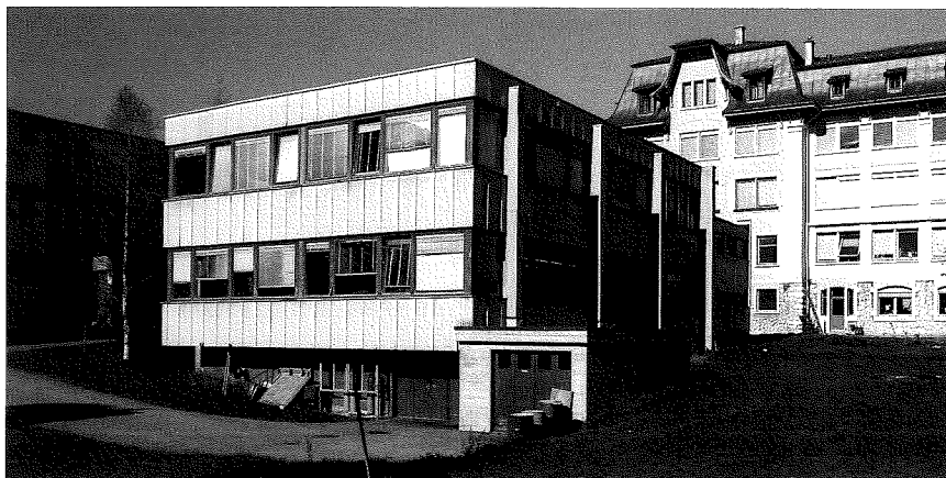
Vue de l'ancienne annexe avant démolition
