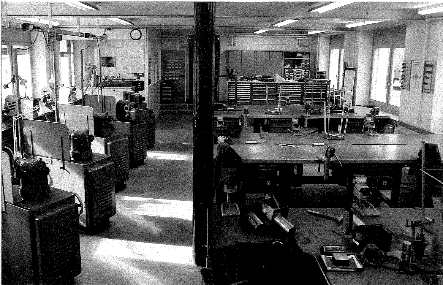
Atelier dans le bâtiment principal, avant transformation (1996).
