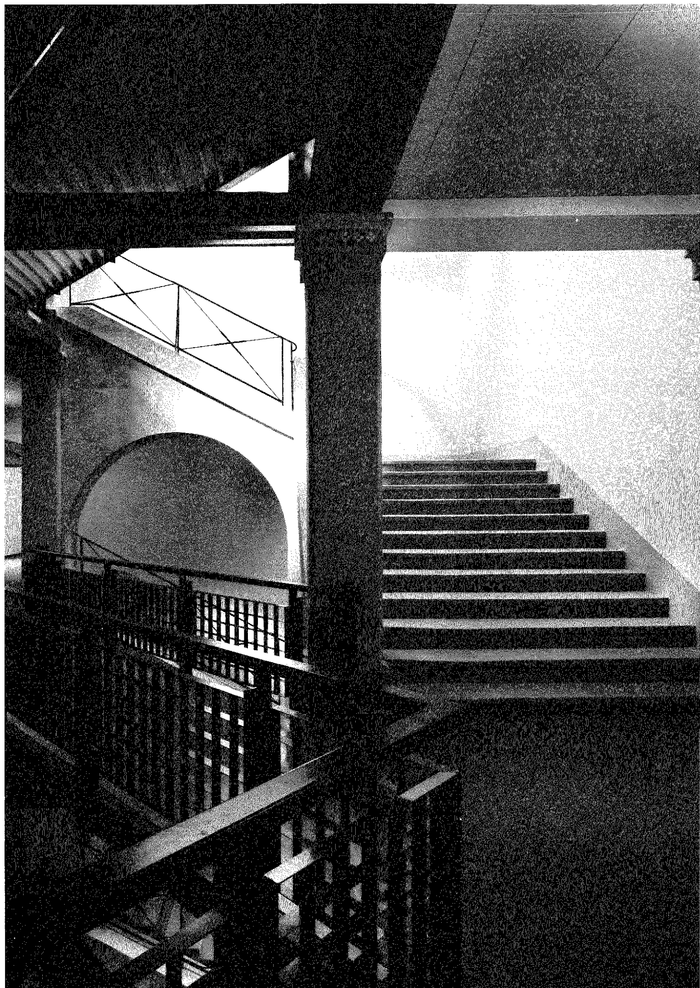
Escalier principal au 2ème étage
