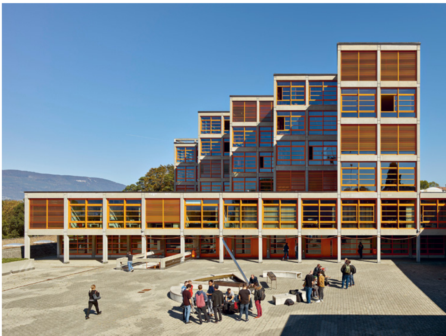
HEIG-VD, Yverdon-les-Bains – Un exemple de patrimoine du XX e siècle rénové en 2018
