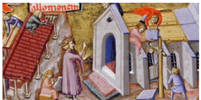
LA COUVERTURE Couvresseurs posant une toitures de tuiles canal. Construction du Temple de Salomon. Après 1331. © BnF
