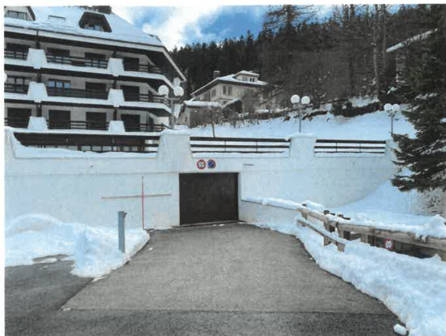
Accès garage souterrain collectif.
