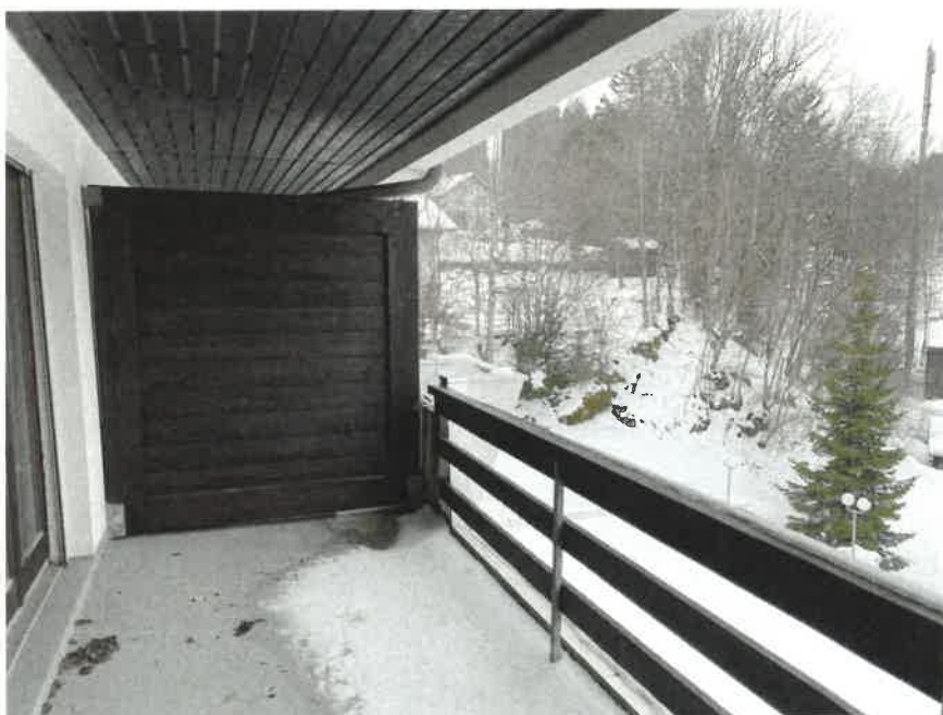
Balcon sur façade nord-ouest, vue en direction sud-ouest.
