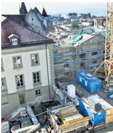
Le chantier du nouveau Parlement cantonal avance à grands pas à Lausanne. PATRICK MARTIN
