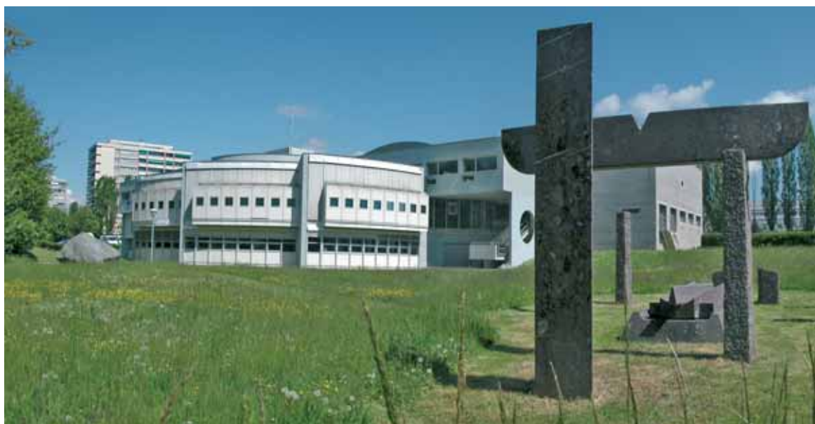
Vue sud-est du bâtiment des ACV.
