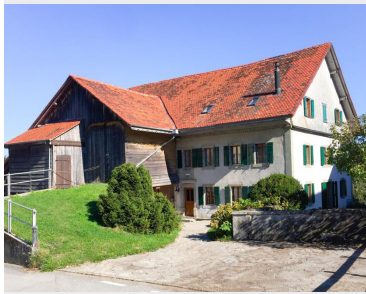
Façade principale et pignon Vue depuis le village
