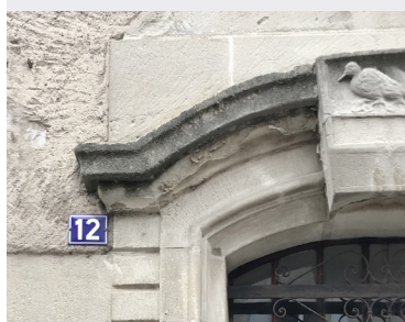
Les ornements et la porte d'entrée en bois sont préservées
