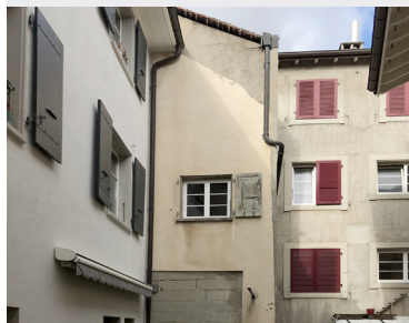
Une isolation en silicate de calcium est appliquée côté cour
