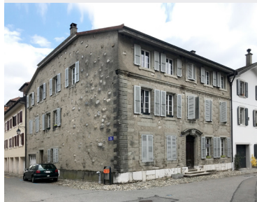
Un crépi isolant permet de garder les nombreux éléments décoratifs sur rue
