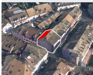
Des tuiles solaires couvrent le pan de toiture côté cour
