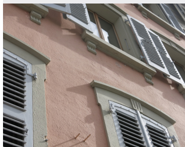
Détail des embrasures et décors en molasse de la façade rue
