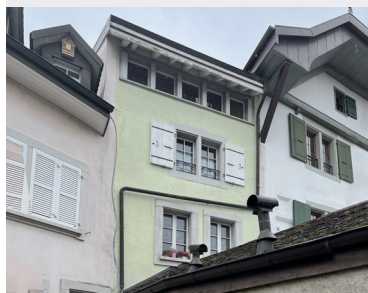
Crépi isolant minéral sur la façade arrière plus modeste
