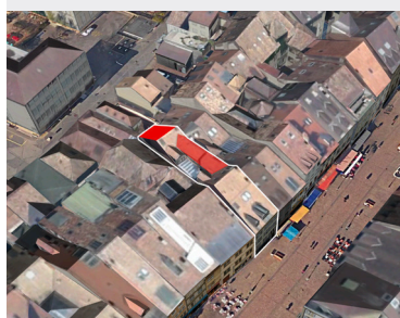
Tuiles photovoltaïques côté rue arrière et panneaux solaires sur cour
