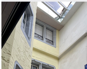
Cour intérieure couverte avec triples vitrages et ouvrants automatiques
