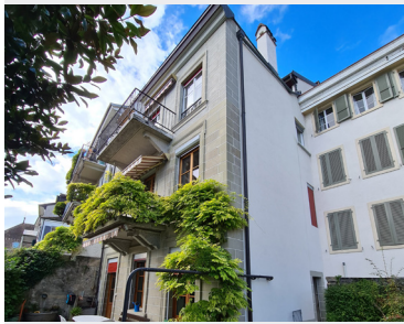
Façade arrière du bâtiment côté jardin et lac
