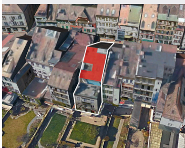
Tuiles photovoltaïques Localisation sur la toiture côté lac.
