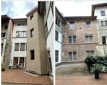
Façades cour en partie crépées
