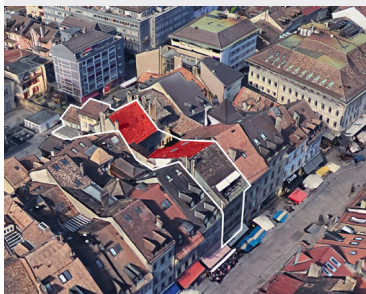
Les pans de toiture côté cour sont couverts de tuiles photovoltaïques
