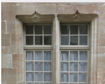
Fenêtres historiques en bois avec simples vitrages présentes dans la cour
