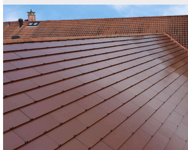
Les panneaux rouges remplacent les tuiles et s'intègrent dans le contexte Référence voir fiche méthodologie
