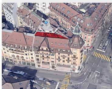
Toitures côté cour; pose d'une bande de panneaux photovoltaïques
