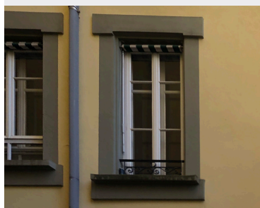
Fenêtres d'origine avec deux fenêtres avec simple vitrage
