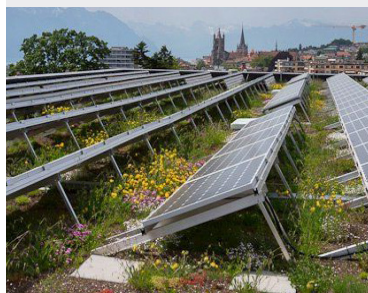
La toiture plate végétalisée intègre des panneaux photovoltaïques qui ne sont pas visibles depuis le domaine public. Référence voir fiche méthodologie
