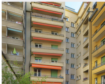
Façade cour, isolée par l'extérieur
