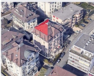
Vue aérienne de l'intégration des tuiles photovoltaïques sur la toiture
