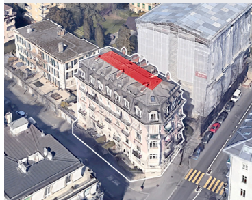
Intégration des panneaux photovoltaïques peu visible sur la partie supérieure de la toiture à Mansart.
