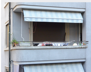
La dalle des loggias est isolée et la main courante surélevée.
