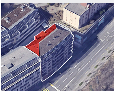
La toiture côté cour est couverte de panneaux photovoltaïques intégrés.
