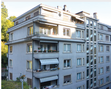
Vue sur la façade côté cour
