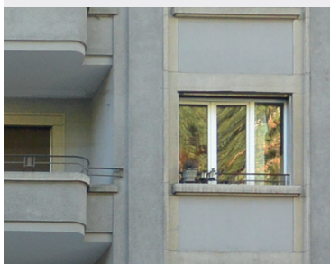
Un crépi isolant permet de garder les modénatures des façades.
