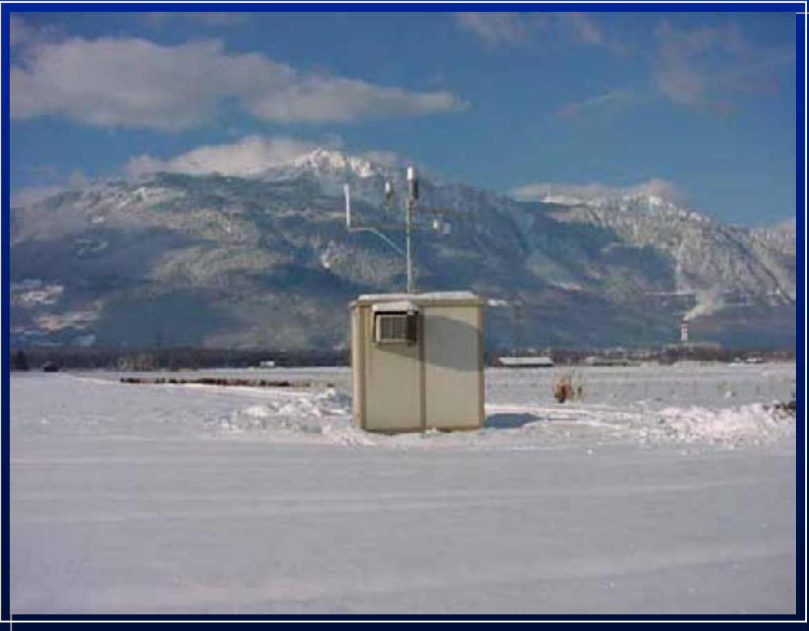
Station du réseau Vaud'Air (Villy-Ollon)
