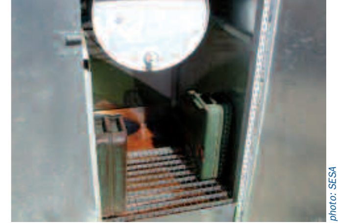
Stockage de contenant d'hydrocarbures sous couvert et sur bac de rétention.
