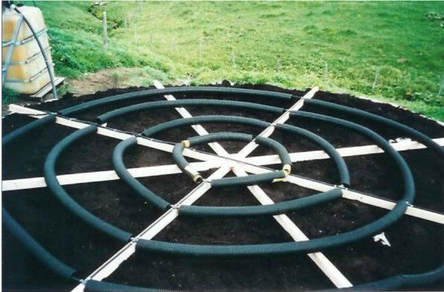
Photo 4: Exemple de disposition du réseau d'injection dans le compost
