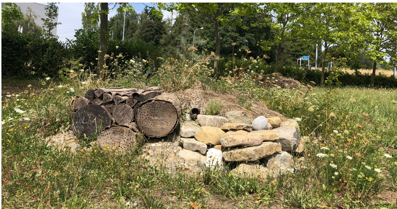
Mise en place d'un murgier
