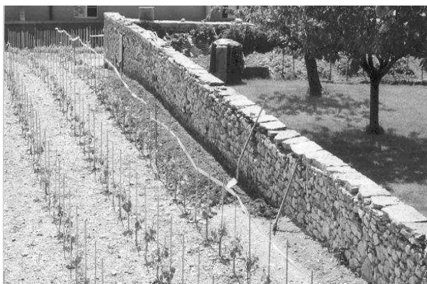
Mur d'enceinte de jardin de Cure avant le crépissage.
