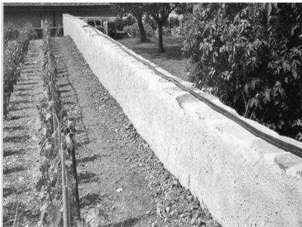
Le même mur après les travaux.
