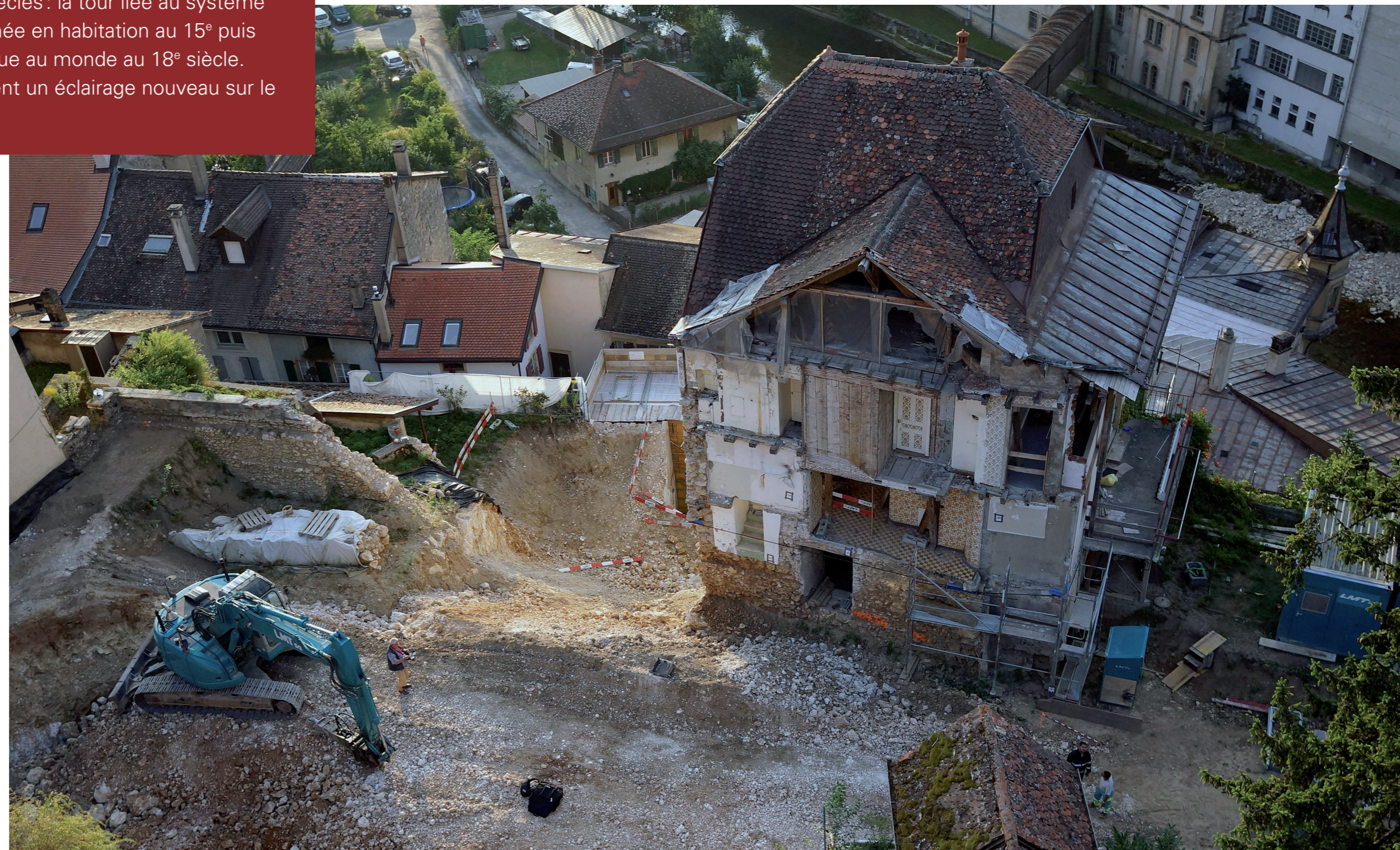
Fig. 1 Vue aérienne du chantier avec la tour à droite et le mur d'enceinte à gauche (photo Archéotech SA, O. Feihl).
