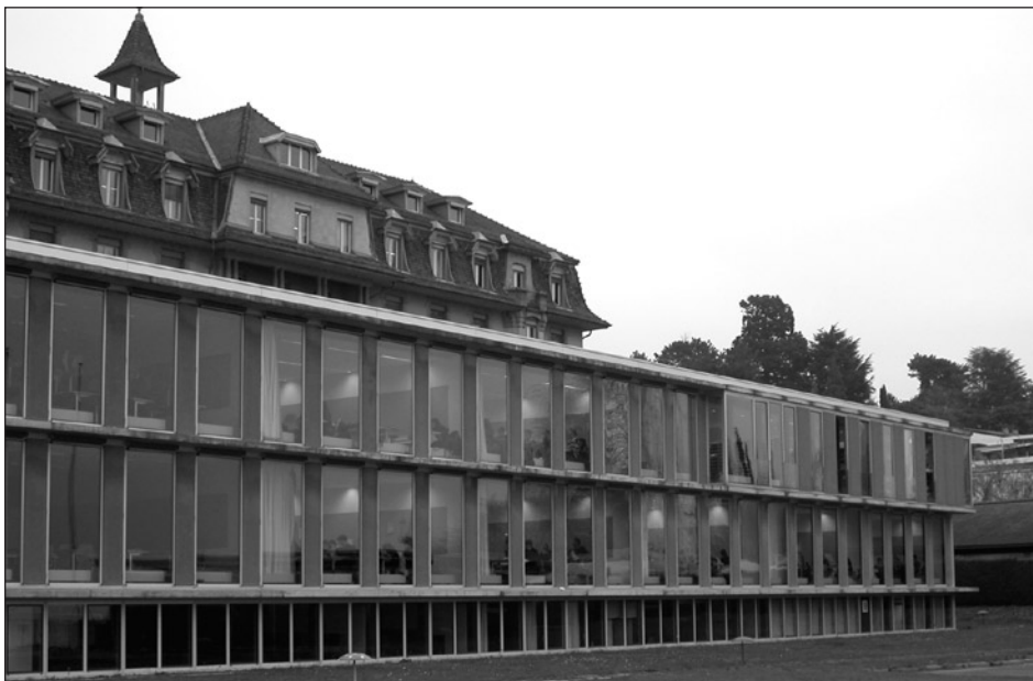
Par sa qualité architecturale et une bonne gestion des installations par le concierge, M. Benjama, le gymnase de Chamblandes (ancien bâtiment à l'arrière et nouvelle aile vitrée devant) possède un indice énergétique équivalent à la moitié de Minergie.
