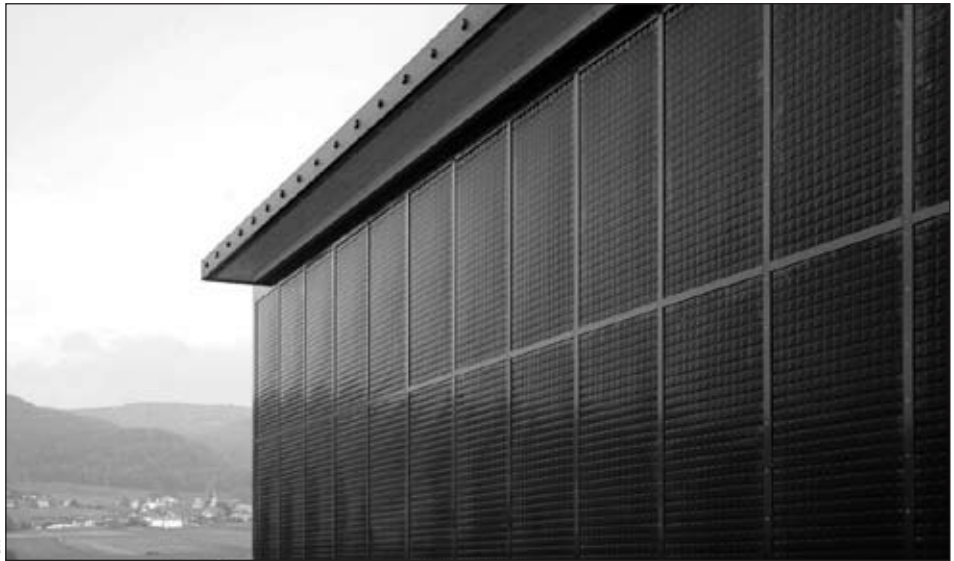
Paroi recouverte de panneaux solaires du nouveau Centre d'entretien des routes nationales de Bursins.
