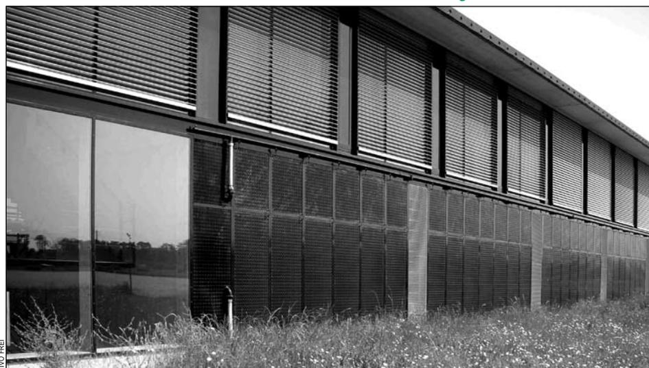
*Façade sud du Centre d'exploitation autoroutier de Bursins. L'énergie solaire couvre 40% des besoins en chauffage du bâtiment.*
