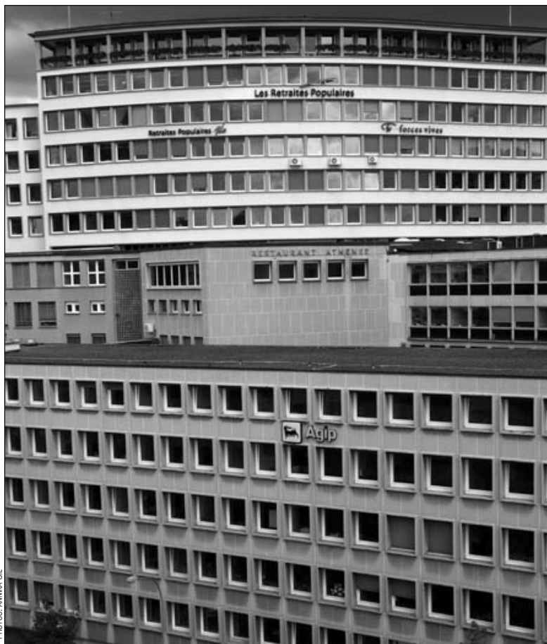
Telle les alvéoles d'une ruche, les bureaux de la rue Caroline 11, qui abritent notamment des services du Département de l'économie, se ressemblent par la forme mais se distinguent par l'aménagement.
