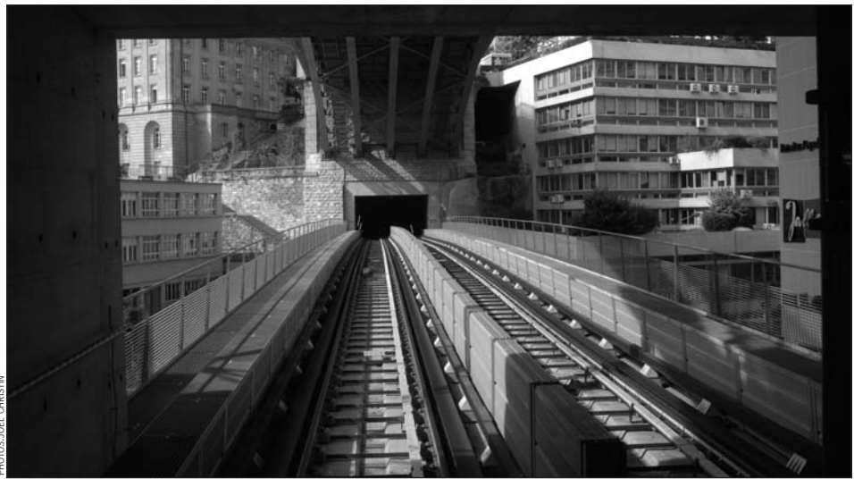
Les dessous du Pont Bessières vus depuis une rame du m2.
