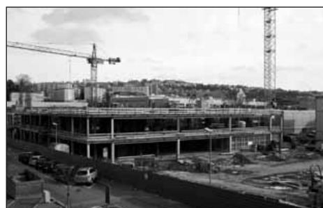
Avancement de la construction en février 2010.
