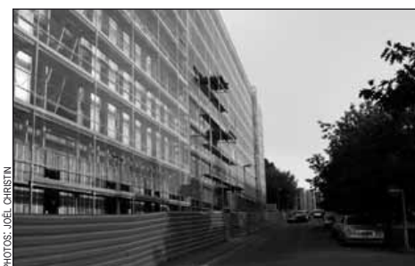
Etat du chantier en août 2010.
