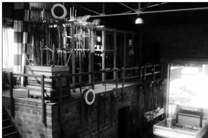
Dépôt de matériel à Curtilles, dans le Région Nord.
