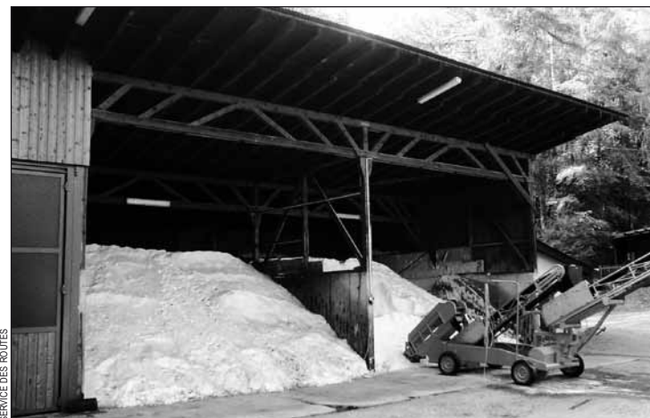
Stock de sel à L'Isle où sera construit un des quatre silos à sel prévus.
