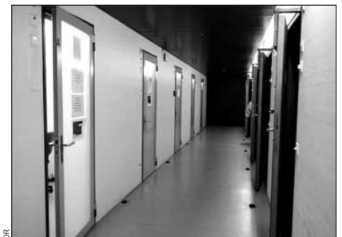
Les locaux d'audition de la zone carcérale au Centre de la Blécherette ont été adaptés aux normes Codex pour pouvoir dès 2011 accueillir davantage de personnes (avocats de la première heure et éventuellement d'autres parties).
