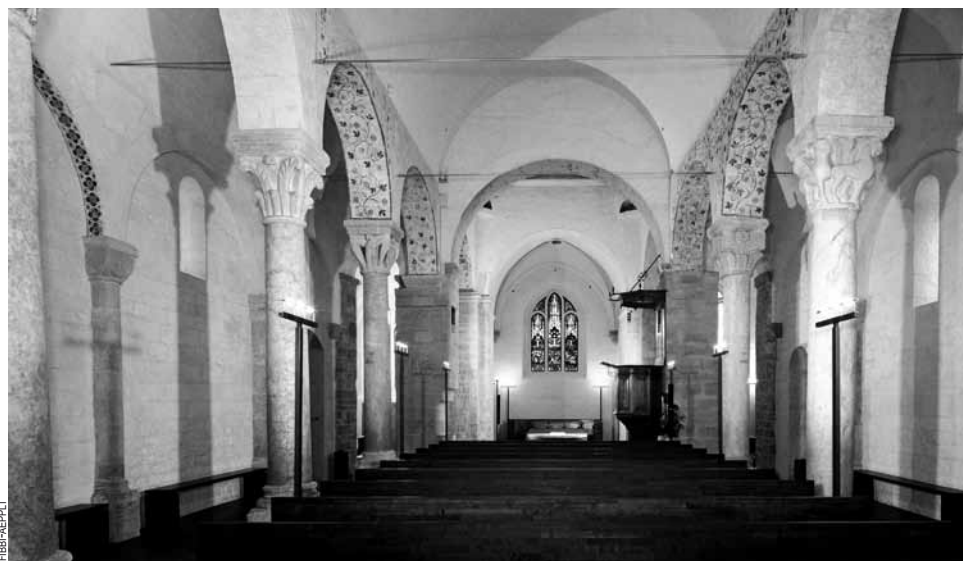
Préservation et valorisation du patrimoine immobilier sont essentielles, en particulier pour les édifices significatifs tels l'église médiévale Saint-Jean Baptiste, à Grandson, qui a fait l'objet d'une restauration.
