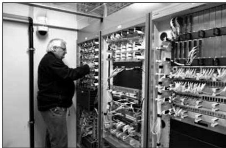
Data center: distribution du réseau.
