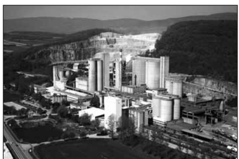
Usine Holcim à Eclépens.
