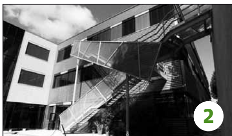
Ancienne usine Iril, à Renens, transformée en Ecole cantonale d'art (ECAL). L: Elle a connu des hauts, mais surtout beaucoup de bas avant de fermer.
