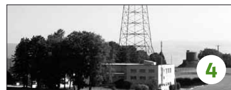
Pylône RSR de Sottens R: Son ancêtre se trouvait à l'emplacement de l'ancien hôpital cantonal.
