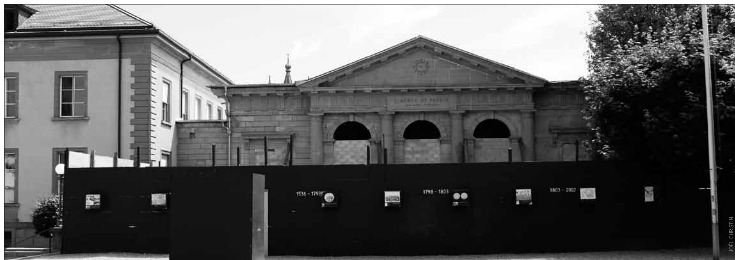
Le Conseil d'Etat est soucieux de ne pas laisser la ruine du bâtiment Perregaux incendié il y a plus de 10 ans défigurer encore longtemps la Cité.
