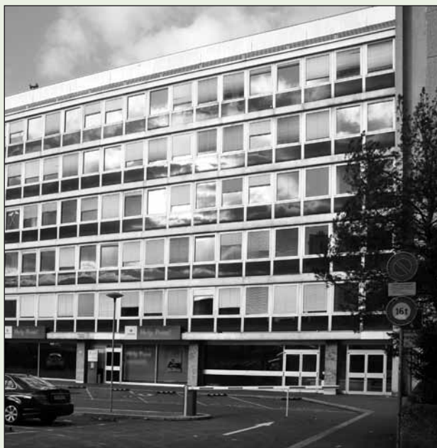
Des travaux vont être entrepris dans les locaux pour créer de nouvelles salles et optimiser l'espace de l'office au ch. de Mornex 32.
