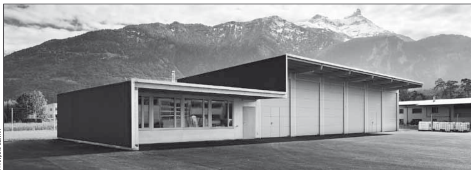
Le bâtiment inauguré à Bex, construit sur le même plan que celui de Sainte-Croix.
