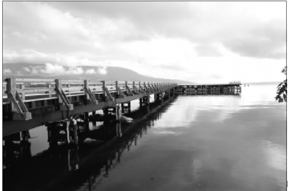
Les travaux liés à l'exposition nationale sont en cours à Yverdon-les-Bains. Outre l'hôtel modulaire déjà en fonction, un ponton en bois qui mènera au «Pavillon des mariages», ainsi qu'une passerelle d'accès qui permettra la construction du «nuage» de l'artéplage ont été réalisés.
