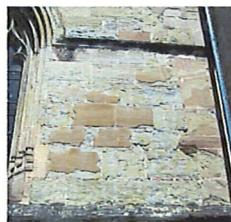
1 Cathédrale de Lausanne, nef nord, à droite, détail du 23 avril 2012. Exemple de percement effectué par des altérations en plaques pas encore traitées (Photo CFC, KIC).
