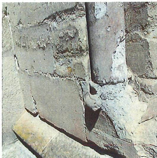
dégradations et pertes des éléments des façades
