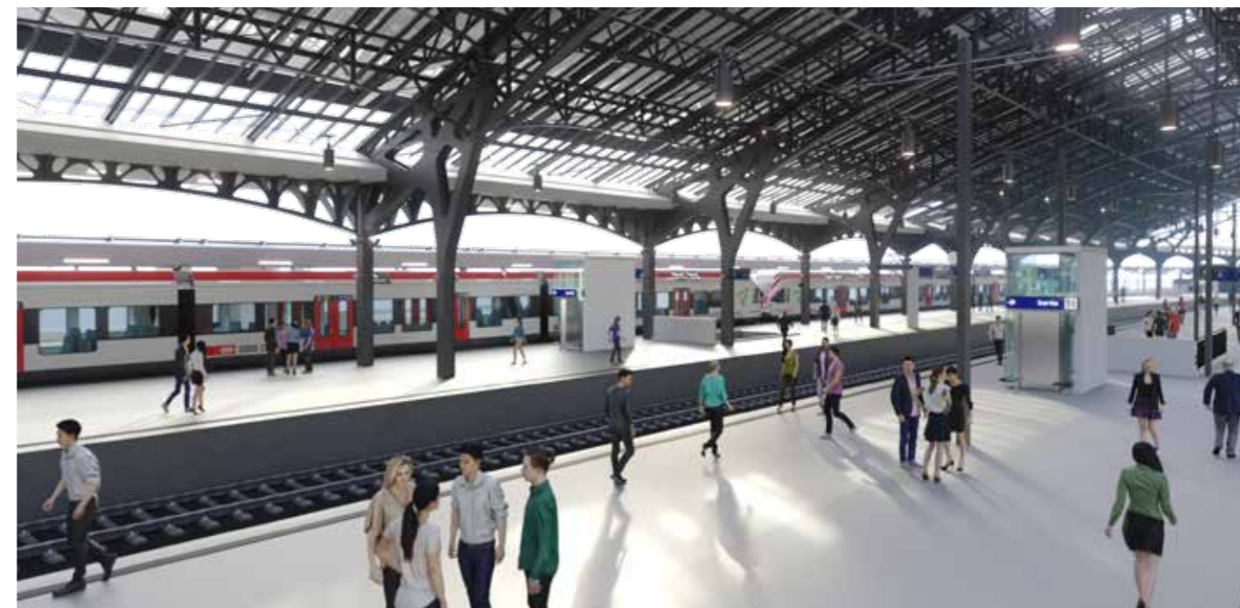
Les futurs quais de la gare de Lausanne, élargis pour faciliter l'accès des passagers et allongés pour accueillir des trains de 400 mètres de long.
