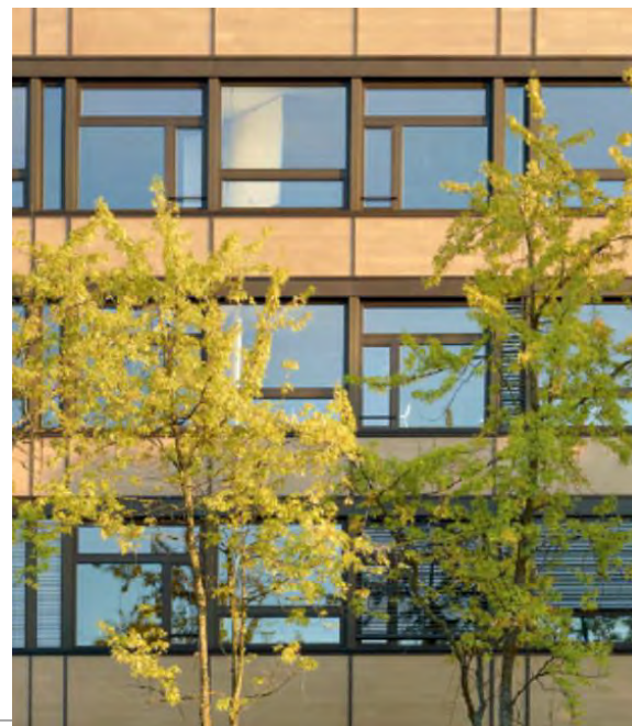
Gymnase d'Yverdon – Assainissement énergétique 2014
