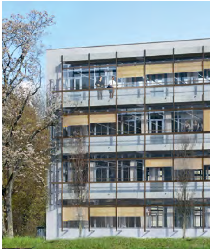
Amphipôle, UNIL, Lausanne Dorigny – Rénovation 2028
