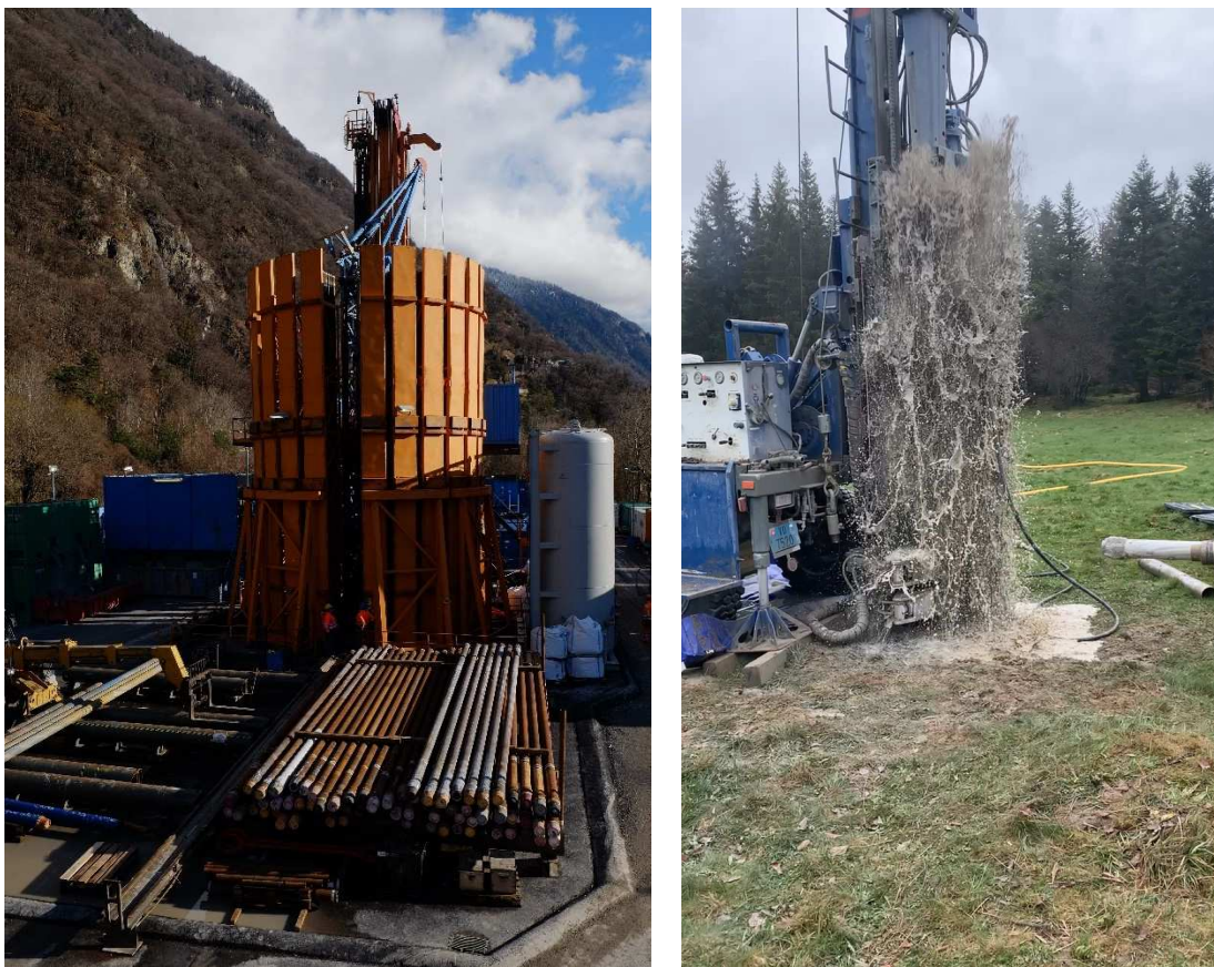
Figure 6 – Photos présentant deux types d'ateliers de forage. A gauche, un forage profond à Lavey-les-Bains nécessitant des investissements élevés – à droite un forage peu profond à la Vallée de Joux, type d'appareil pouvant être déployé par exemple pour la prospection d'eau potable.
