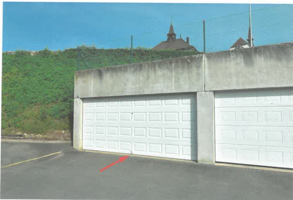
Photo N°3 Façade du garage (lot)
