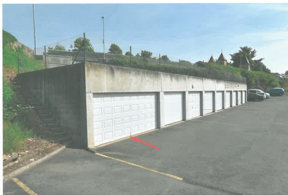
Photo N°2 Vue générale des garages avec emplacement du lot
