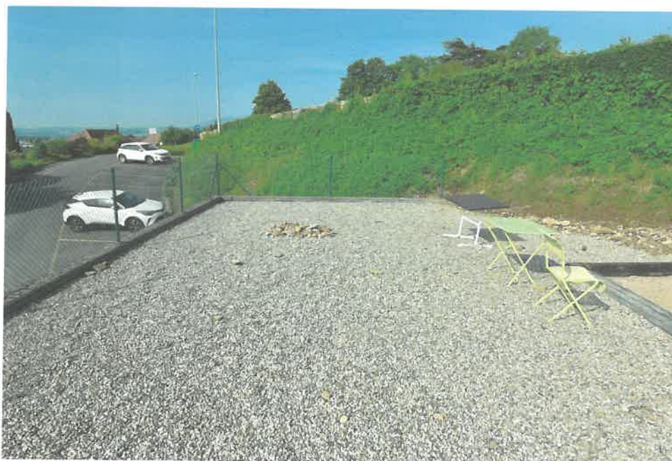
Photo N°4 Toiture des garages
