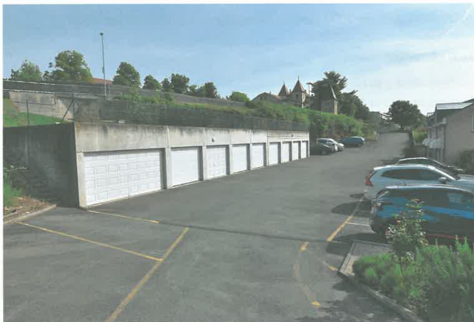
Photo N°1 Place goudronnée devant les garages (pour l'accès et les manœuvres)
