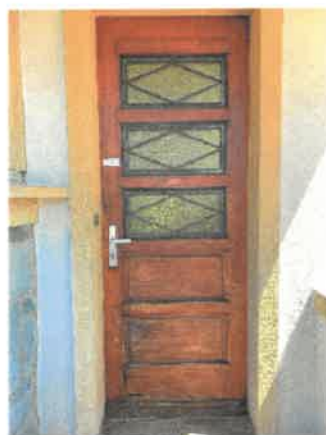
Porte entrée office cuisine
