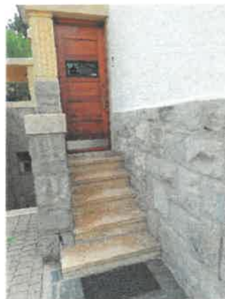
Porte entrée de service
